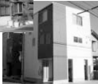
軒の出がなく・窓上ひさしもない最近の住宅
