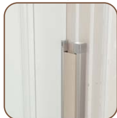
ドアの吊元側に設置
