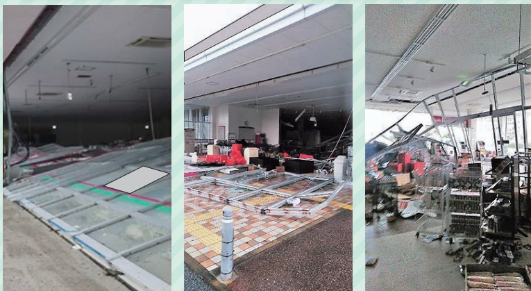
国土交通省国土技術政策総合研究所・国立研究開発法人建築研究所資料 「平成30年台風第21号に伴う強風による建築物等被害現地調査報告（速報）」より転載
